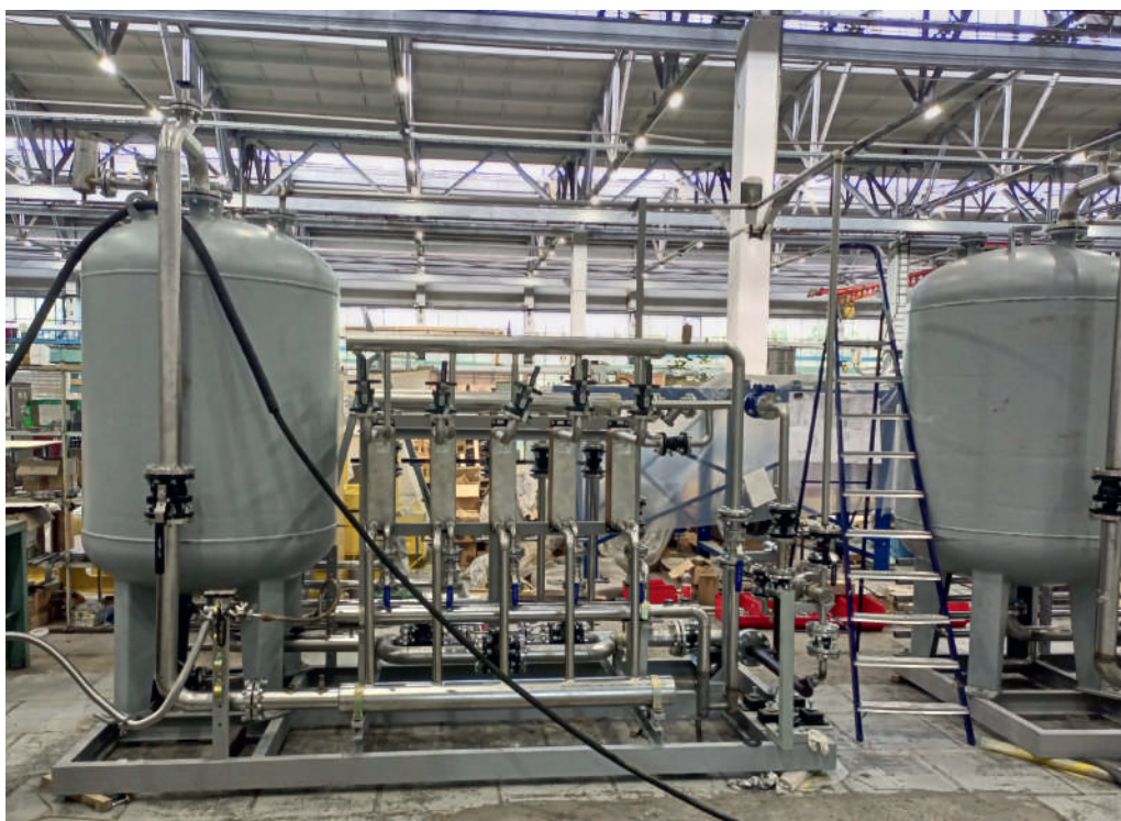
Рис. 9. Фотография масляных систем в процессе изготовления.
